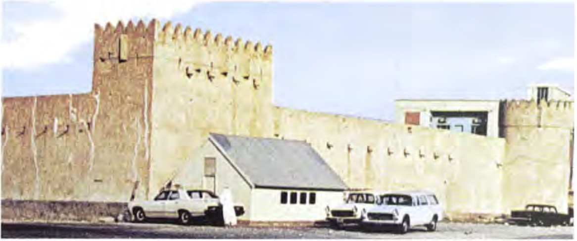
منظر عام من الجهة الغربية للقلعة (الكوت) قبل الترميم
